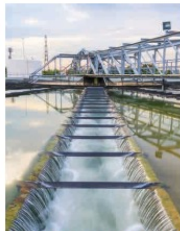
Hình 10. Hệ thống xử lý nước thải ở Thái Lan
